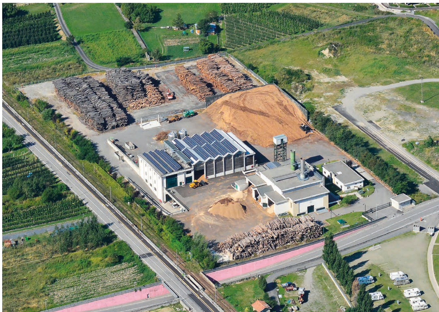
PER LA PARTE TERMICA, LA RETE DI TELERISCALDAMENTO È GIÀ OGGI IN GRADO DI COPRIRE CIRCA L'80% DEL FABBISOGNO ENERGETICO TERMICO DI TIRANO
