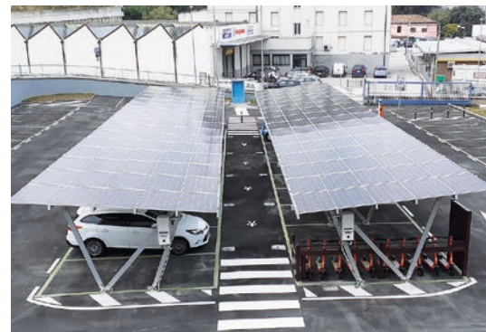
L'AREA PREVEDE UNA SUPERFICIE FOTOVOLTAICA DI 296 METRI QUADRATI COPERTI DA 160 MODULI FOTOVOLTAICI MONOCRISTALLINI DA 330 WP FU330M NEXT DI FUTURASUN
