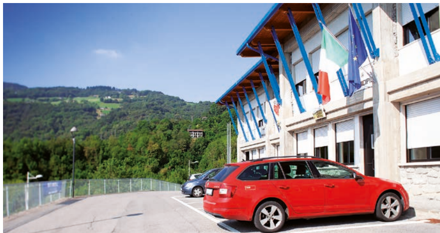
IL COMUNE DI GAVERINA NON SI È LIMITATO ALLA RIQUALIFICAZIONE DELL'IMPIANTO. SONO INFATTI STATI SOSTITUITI ANCHE TUTTI I CIRCOLATORI DEL CIRCUITO SECONDARIO E SOPRATTUTTO È STATA PREDISPOSTA LA GESTIONE DIGITALIZZATA DELL'IMPIANTO
