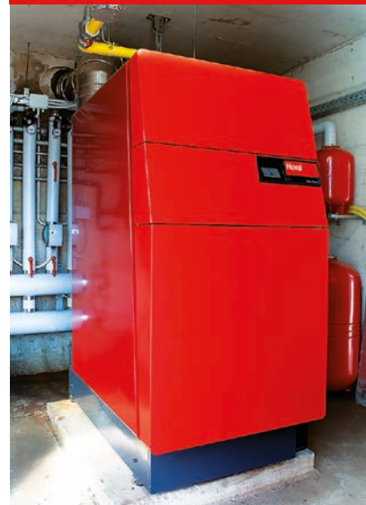
IL VECCHIO IMPIANTO, CHE SERVE L'EDIFICIO COMUNALE, L'UFFICIO POSTALE E IL PLESSO SCOLASTICO GIANNI RODARI, È STATO SOSTITUITO CON UNA CALDAIA A GAS A CONDENSAZIONE HOVAL ULTRAGAS® 250 AD ALTA EFFICIENZA
