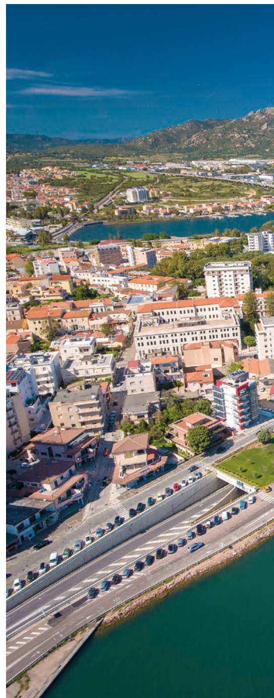
A OLBIA IL PARTENARIATO CON SIRAM VEOLIA PUNTA ALLA RIQUALIFICAZIONE IMPIANTISTICA E ALL'OTTIMIZZAZIONE ENERGETICA DEGLI IMMOBILI. IL PIANO AVRÀ UNA DURATA DI 19 ANNI E INTERESSERÀ 43 EDIFICI
