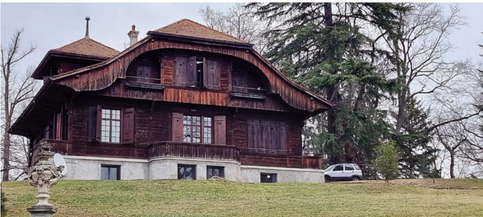
UN INTERVENTO IMPORTANTE, I CUI FINANZIAMENTI AMMONTANO A OLTRE 14 MILIONI DI EURO, RIGUARDA LA STORICA VILLA BARAGIOLA, NEL QUARTIERE MASNAGO. IL PROGETTO MIRA A RIQUALIFICARE LA VILLA CON INTERVENTI DI CONSERVAZIONE, STRUTTURALI, IMPIANTISTICI, ARCHITETTONICI E DI PAESAGGIO
