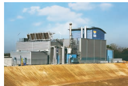
LA CENTRALE A BIOMASSA CON TELERISCALDAMENTO A FILIERA CORTA CHE RECUPERA IL LEGNAME DELLE AZIENDE DEL TERRITORIO
