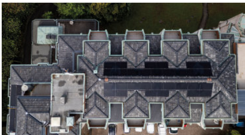
AL CENTRO DEL PROGETTO, L'INSTALLAZIONE DI UN IMPIANTO FOTOVOLTAICO IN COPERTURA DA 20 KWP, IN GRADO DI GENERARE CIRCA 21.000 KWH ALL'ANNO
