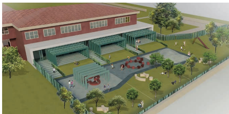
GLI INTERVENTI DI ADEGUAMENTO ALLE NORME DI SICUREZZA ANTINCENDIO ED EFFICIENTAMENTO ENERGETICO DELLA SCUOLA PRIMARIA SANDRO PERTINI HANNO UN VALORE DI CIRCA 1 MILIONE DI EURO
