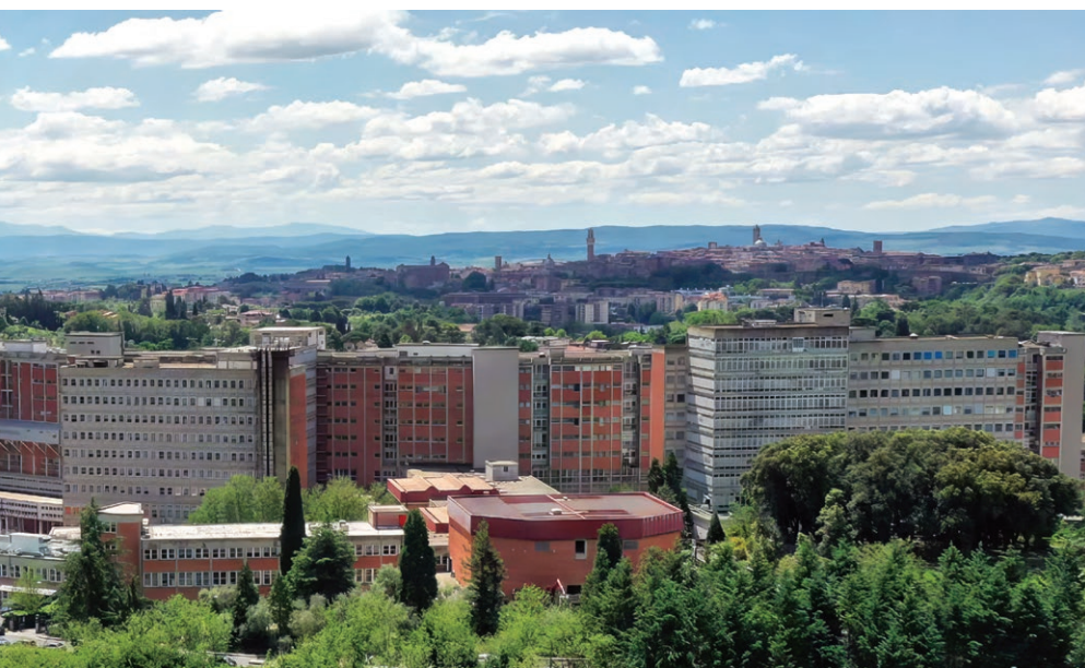
IN QUESTI ANNI RENOVIT HA AVVIATO NUMEROSE PROGETTUALITÀ DI GRANDE RILIEVO. NELLA FOTO, L'OSPEDALE SANTA MARIA ALLE SCOTTE DI SIENA, OGGETTO DI RIQUALIFICAZIONE E GESTIONE ENERGETICA
