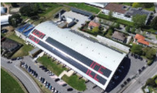
L'ACINQUE ICE ARENA A VARESE, CHE È STATA TRASFORMATA IN UN IMPIANTO POLIFUNZIONALE PIÙ EFFICIENTE E SOSTENIBILE GRAZIE ALL'INTEGRAZIONE DI FONTI RINNOVABILI E SISTEMI DI RECUPERO ENERGETICO, È UN CONCRETO ESEMPIO DI PARTENARIATO PUBBLICO-PRIVATO
