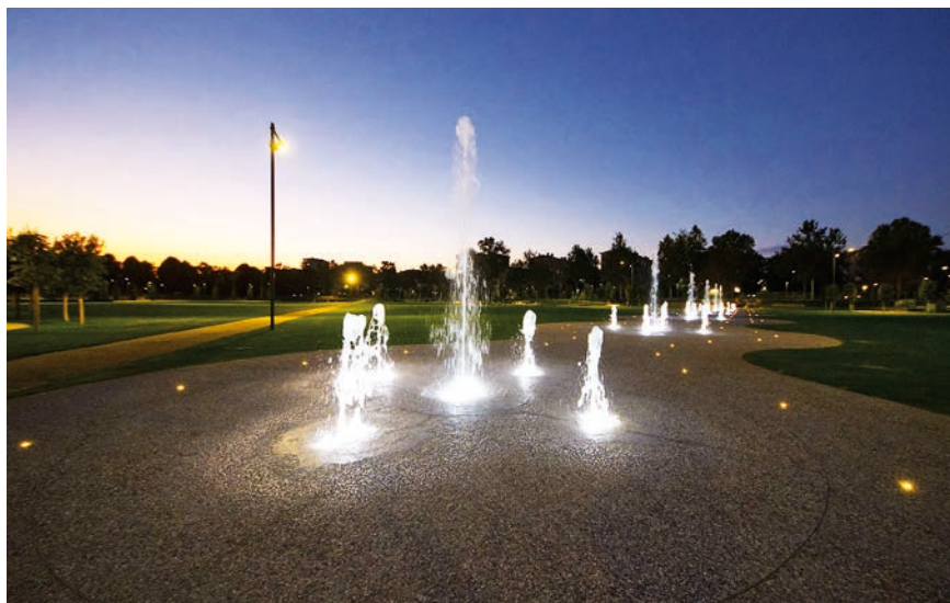
LA TECNOLOGIA DEL RICICLO DELL'ACQUA NEI GIOCHI DELLA FONTANA, INSIEME ALLA REGOLAZIONE DELL'IMPIANTO IRRIGUO COL SUPPORTO DI UNA STAZIONE METEO, OTTIMIZZANO IL CONSUMO DELLE RISORSE IDRICHE
