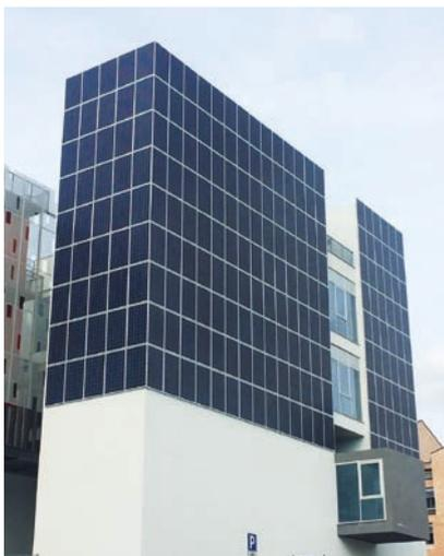
**GLI EDIFICI SCOLASTICI SONO TRA QUELLI PIÙ FREQUENTEMENTE OGGETTO DI INSTALLAZIONI DI FOTOVOLTAICO. QUI SOPRA, UNA SCUOLA DI PERUGIA SU CUI È STATO INSTALLATO UN IMPIANTO SU FACCIATA CON MODULI SUNERG SOLAR POLY, PER UN TOTALE DI 60 KW, OTTENENDO CIRCA IL 40% DI ABBATTIMENTO SUI COSTI DELLA BOLLETTA**
