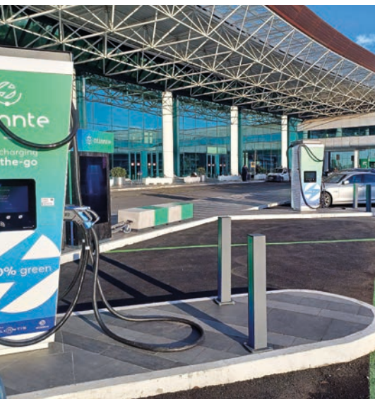
ATLANTE HA INAUGURATO LO SCORSO SETTEMBRE LE COLONNINE HPC PRESSO L'AEROPORTO DI FIUMICINO
